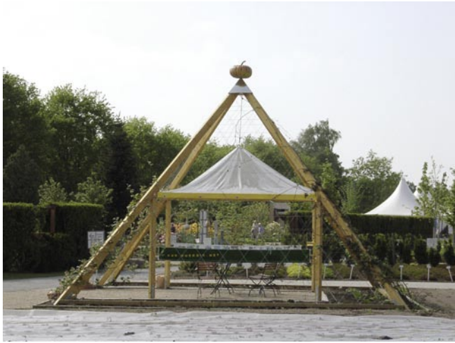
Mit Überdachung aus starker Folie.
