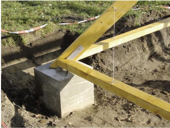
Mußte das so stabil sein? 50x50x50 cm Betonklötze dass keine größeren Pyramiden gebaut wurden.
