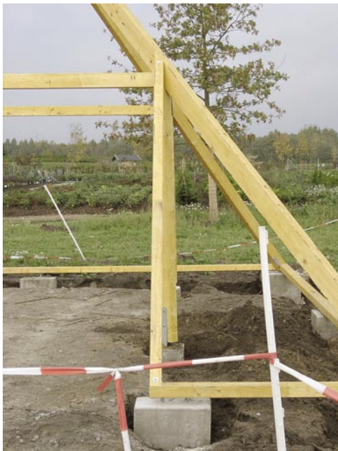
Mußte das so stabil sein? 50x50x50 cm Betonklötze dass keine größeren Pyramiden gebaut wurden.
