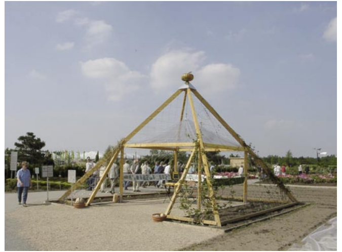
Konstruktion steht: Anpflanzung kann beginnen.
