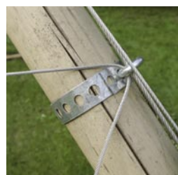
Bambusstange mit Edelstahldrähten bespannt.
